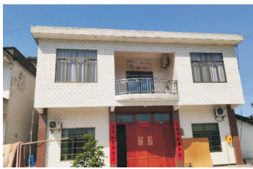
图5 大坝苗族乡红旗村砖混结构房屋基本完好
