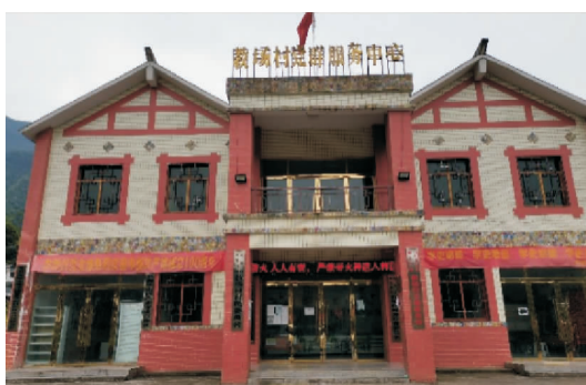
图2 夔王山镇教场村框架结构房屋基本完好
