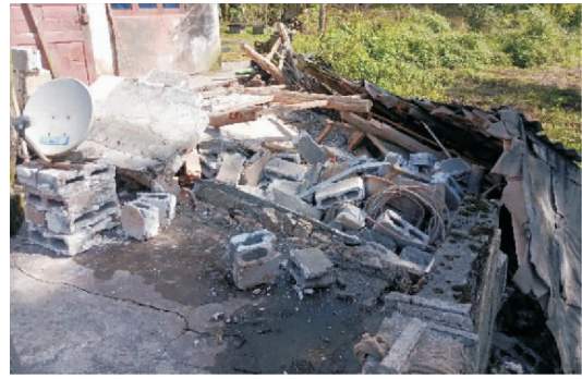
图9 仙峰苗族乡老旧砖木结构房屋因震害叠加坍塌
