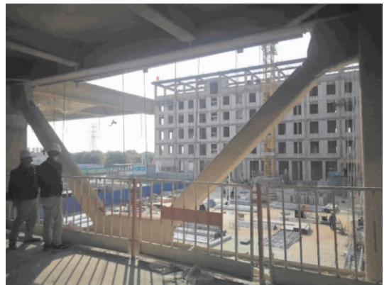
图10 装配式屈曲约束支撑安装完成
